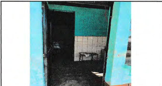
Foto 4: Sustitución de Azulejo 50 M2, 10 metros de largo por 5 metros de ancho.
