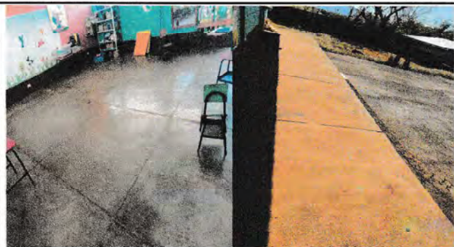
Foto1: Sustitución de Piso Ceramico, 140 M2, 17.5 metros de ancho por 8 metros de largo.
