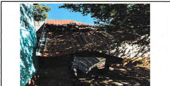
Foto 6: Sustitución de Lamina por Lamina Troquelada 5 metros de largo por 3 de ancho y Sustitución de Estructura de soporte (madera, metal) por Metal. 18ML
