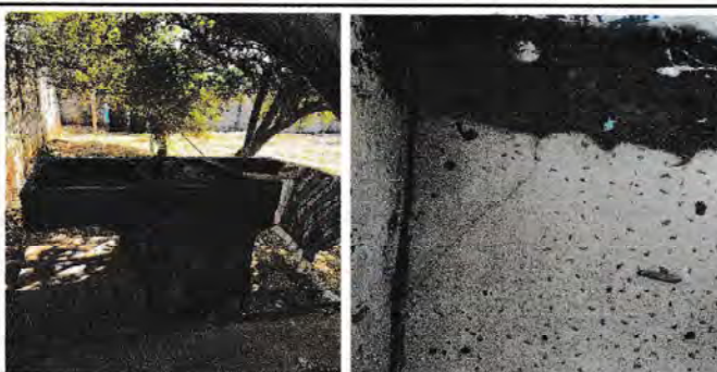
Foto 5: Sustitucion de Pila
