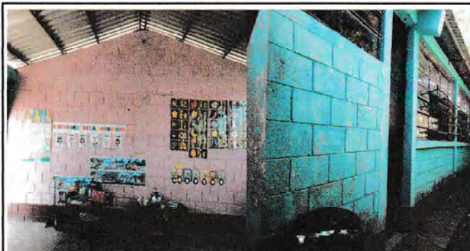
Foto 2: Pintura en Muros Exteriores e Interiores, 150 M2, 3 metros de alto por 50 metros de largo.
